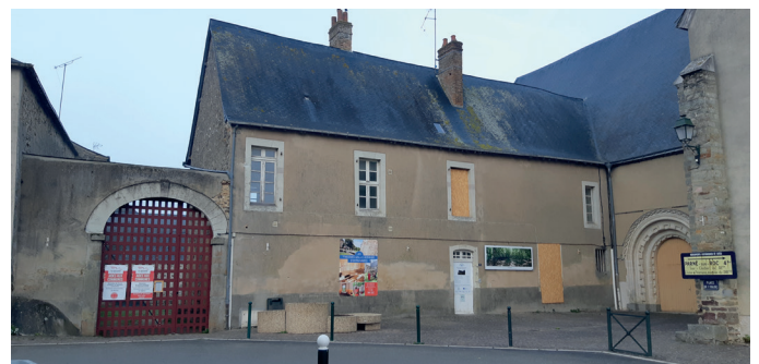
Ancien presbytère avant les travaux
