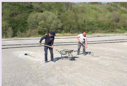
Ce besoin émane de réflexions de joueurs du département et de membres du Comité. En fait, ce sont les infiltrations d'eau de pluie dans ces zones qui nous ont amené à générer ces surépaisseurs. Il fallait donc en complément réaliser un drainage au fond des terrains pour réduire ces infiltrations et diriger ces eaux vers la mare. Nous avons aussi ajouté quatre terrains dans le fond en raison du nombre de triplettes inscrites (125), dont six pour notre club.
