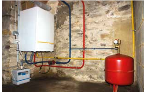
La chaudière de l'ancienne mairie datant des années 70 étant tombée en panne, elle a été remplacée par une chaudière à condensation, le conduit d'évacuation de fumée a été remplacé et quelques améliorations sur l'installation ont été réalisées. Coût : 8 400 €.
