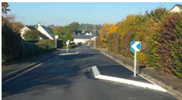
Route de Parné, mise en place d'une écluse et de coussins Berlinoïds, dans le cadre du schéma de circulation apaisée. Coût : 9 810 €, subvention 2 160 €
