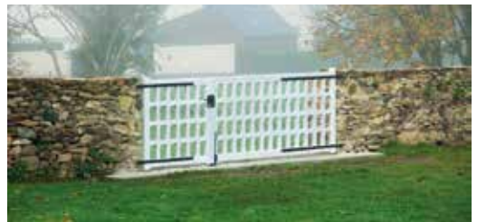
Mise en place d'un portail. Coût : 2 200 €.
