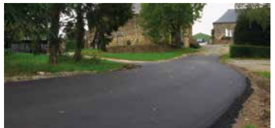
Enrobé ou enduit bi-couche des chemins, rues et trottoir (Montigné, La Grande Roche, Le Haumerand, La Verrie, Impasse des Bourrelliers, et des Meuniers, parking du cimetière, rue des Châtaigniers, du Pessage, de la Croix, et entretien (PATA). Coût total de 80 000 €.
