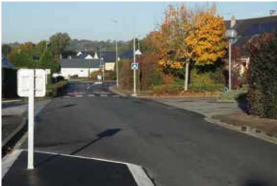
Réaménagement route de Parné - rue des Tisserands
