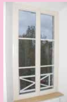
Remplacement de fenêtre à la maison des jeunes
