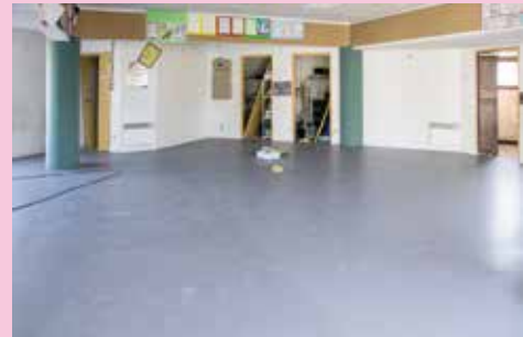
Réfection du sol du hall de l'école primaire
