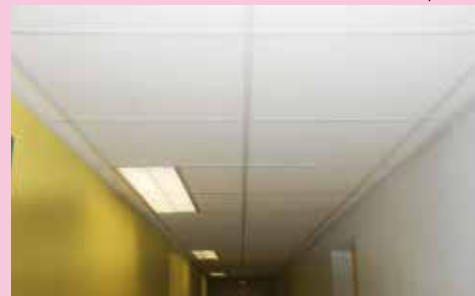
Réfection du plafond du couloir de la salle omnisports
